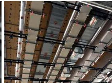
Fixation sous plafond : fixation type AAAF
