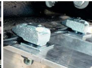
Fixation sur structure gare : fixation type A
