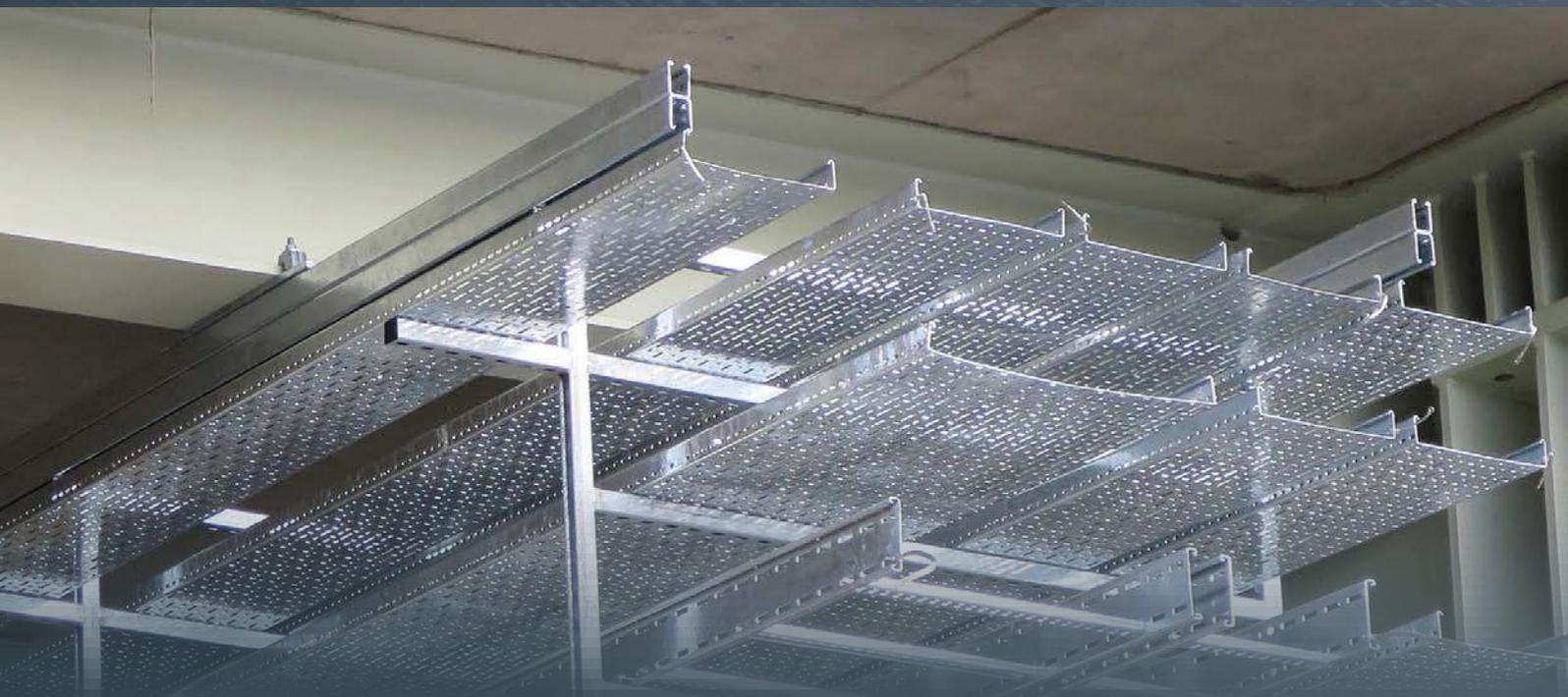
**Les modules RTB préfabriqués sont des unités de réseaux de bâtiments préassemblées hors site à l'aide de techniques de construction modulaire.**
