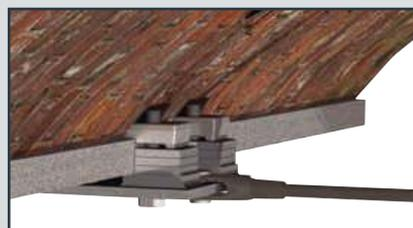
Dans le cadre du projet de modernisation du pont de Camley Street (ancienne liaison ferroviaire du Tunnel sous la Manche) en vue d'accueillir une LGV (HS1), pour renforcer les arcades et empêcher tout mouvement latéral, les armatures de soutien des arcades, abîmées par la corrosion, ont été resserrées grâce à des assemblages à câble réglable. Les crapauds type RC ont été utilisés pour fixer les plaques de ces assemblages aux poutres en fonte d'origine, sans les détériorés.
