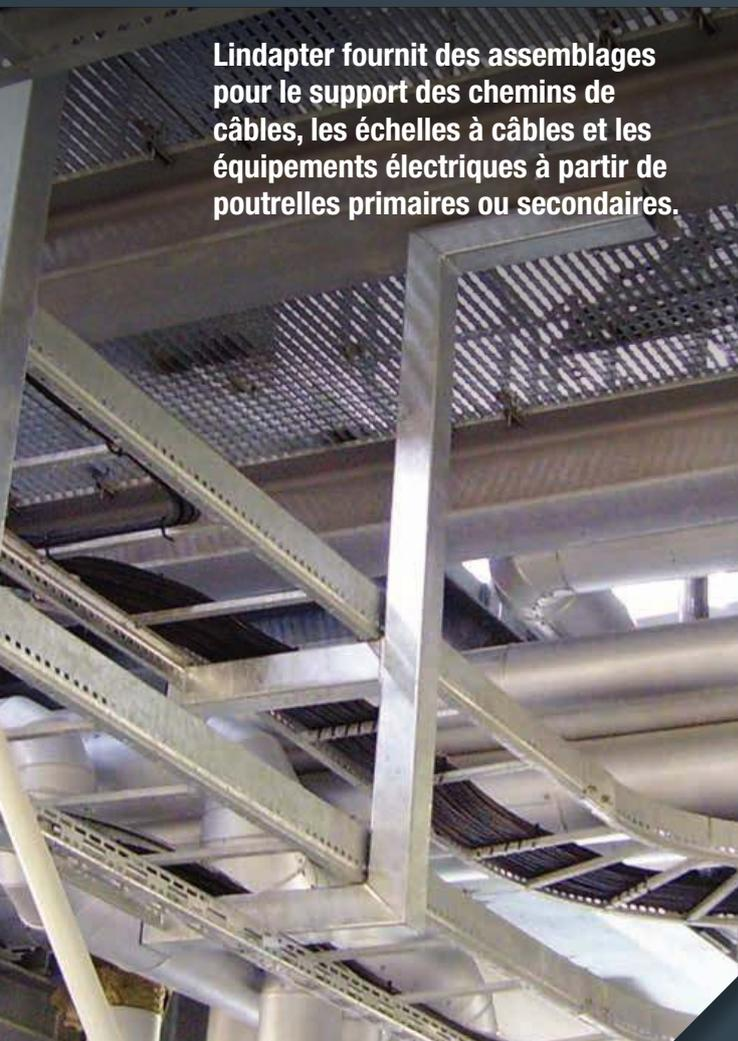
Les chemins de câbles ou équipements peuvent être fixés en configurations simples de résistance à la traction, ou de colonnes verticales résistant au glissement. Grâce au réglage rapide, des systèmes multiples de chemins de câbles / échelles à câbles peuvent être installés facilement pour former des intersections.
