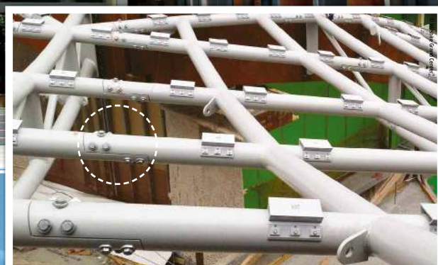
Le Hollo-Bolt utilisé pour l'assemblage par éclisse des profilés creux ronds
