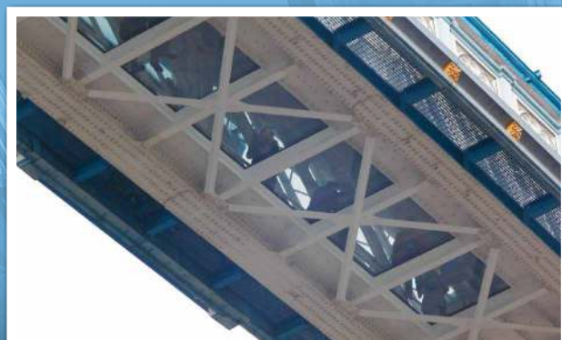
La structure d'origine en treillis métallique a été préservée
