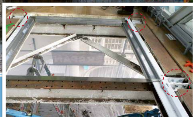
La nouvelle structure reliée par des ailettes en acier et des cadres supports
