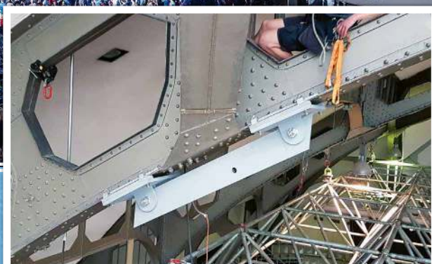
En cours d'installation, le système sur mesure de cadres supports
