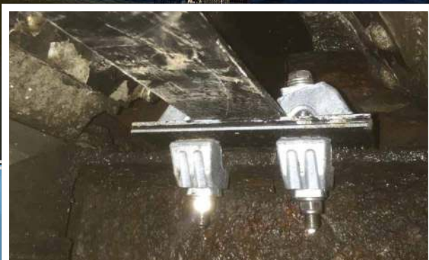
Crapauds de fixation Type AAF utilisés pour assembler les poutres de renforcement
