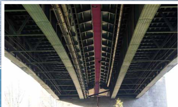
Il fallait renforcer les tabliers du pont métallique
