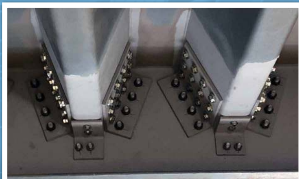
Les Hollo-Bolts fournissent une solution homologuée pour les applications de charge dynamique
