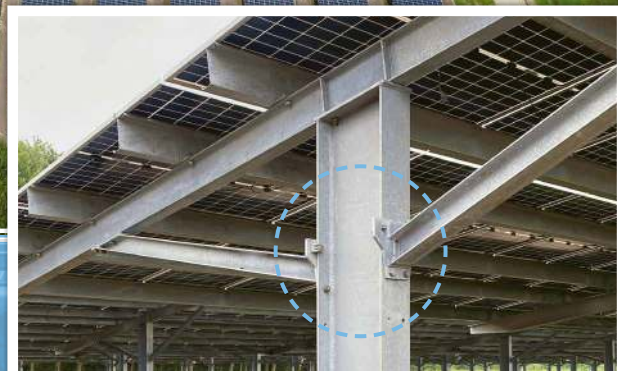
La conception fait intervenir une platine d'extrémité sur mesure en acier
