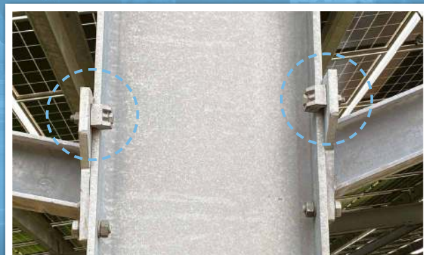
Le Type AF Lindapter à haute résistance au glissement a été spécifié
