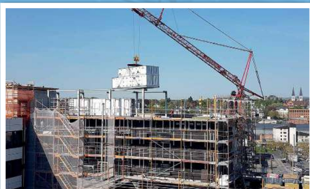
Installation des appareils de climatisation
