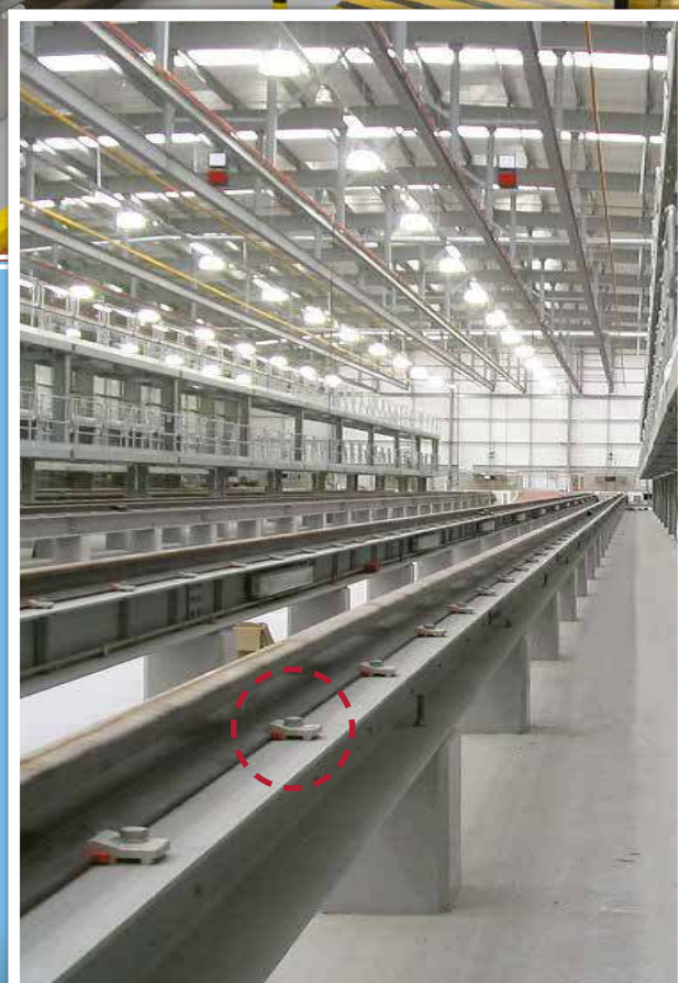
Les crapauds Type HD utilisés pour sécuriser les rails
