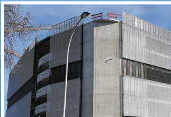
Le bardage en place
