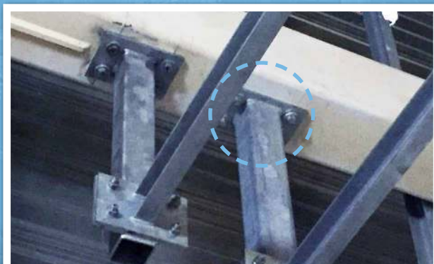
Les Hollo-Bolts utilisés pour relier les suspentes de canalisations
