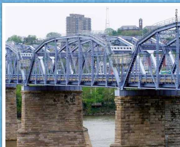
Le pont entièrement rénové a rouvert en 2006
