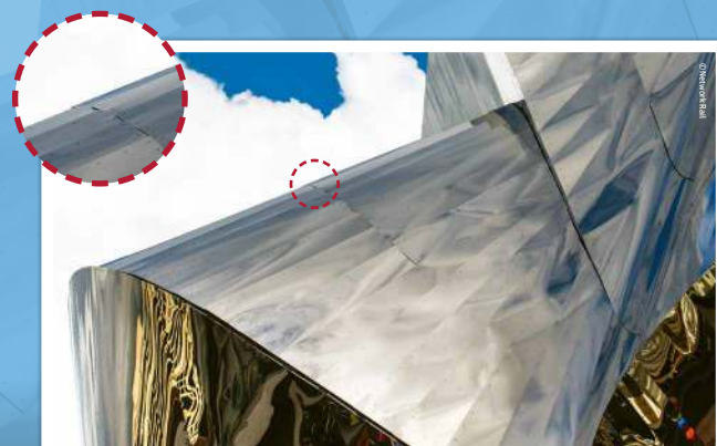
La tête fraisée a permis d'obtenir une finition soignée
