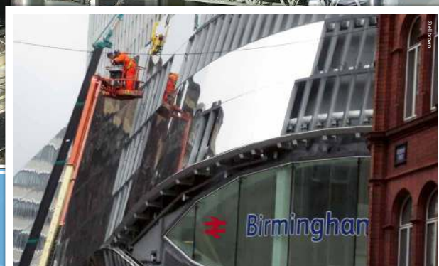
Les Hollo-Bolts utilisés pour assembler les panneaux
