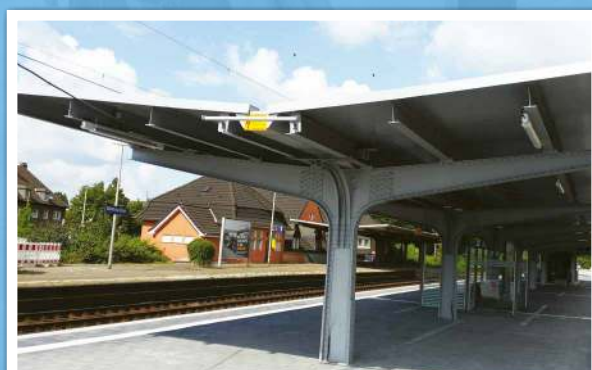
Le nouveau quai réaménagé
