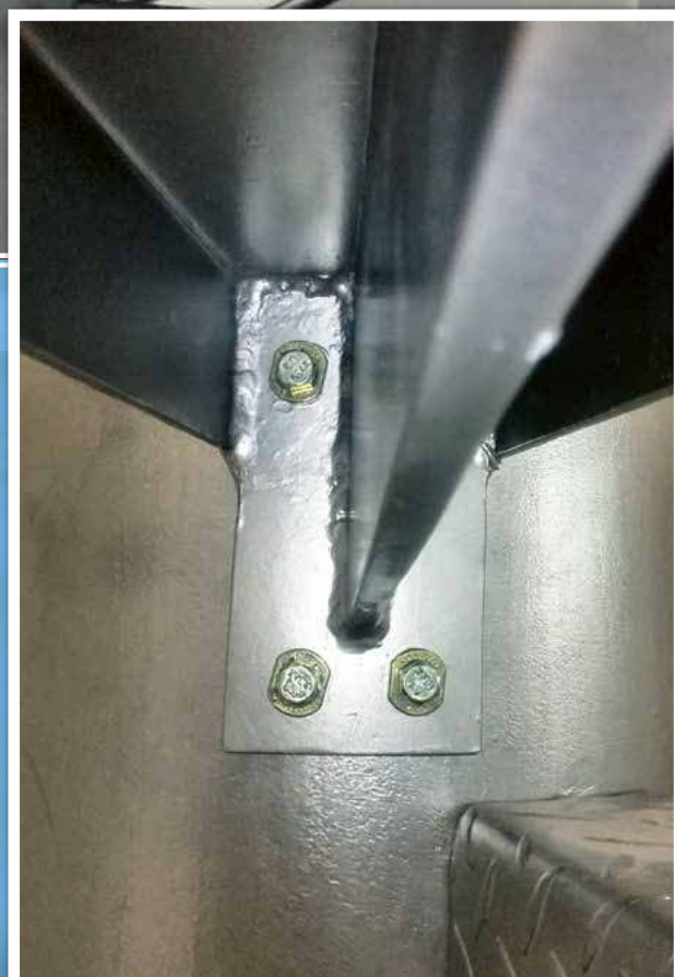
Insertion des Hollo-Bolts dans des trous prépercés
