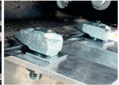
Fixation sur structure gare : fixation type A
