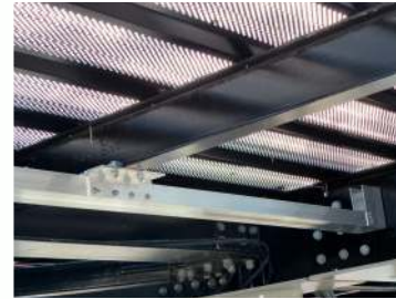
Fixation sur structure gare : fixation type A
