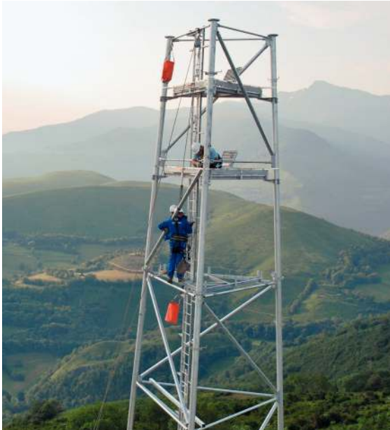
7.6-2 Application de produits galvanisés : pylônes
