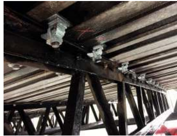
Fixation tablier sous pont suspendu : fixation type LR
