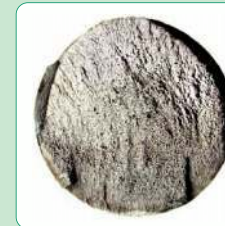
5.6-6 Rupture due à une fragilisation par l'hydrogène
