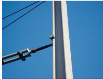
Fixation sur structure tramway : fixation type AF
