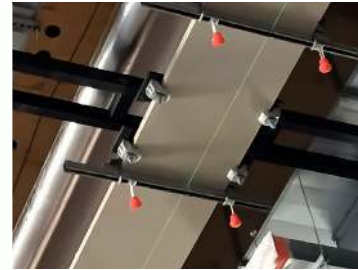
Fixation sous plafond : fixation type AAF
