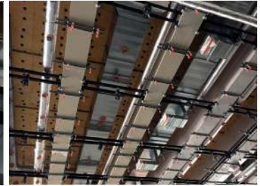
Fixation sous plafond : fixation type AAF
