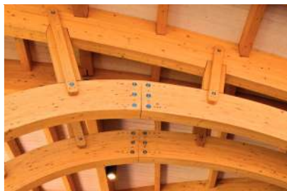
Assemblage de poutres
