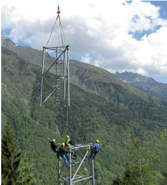
7.6-2 Application de produits galvanisés : pylônes
