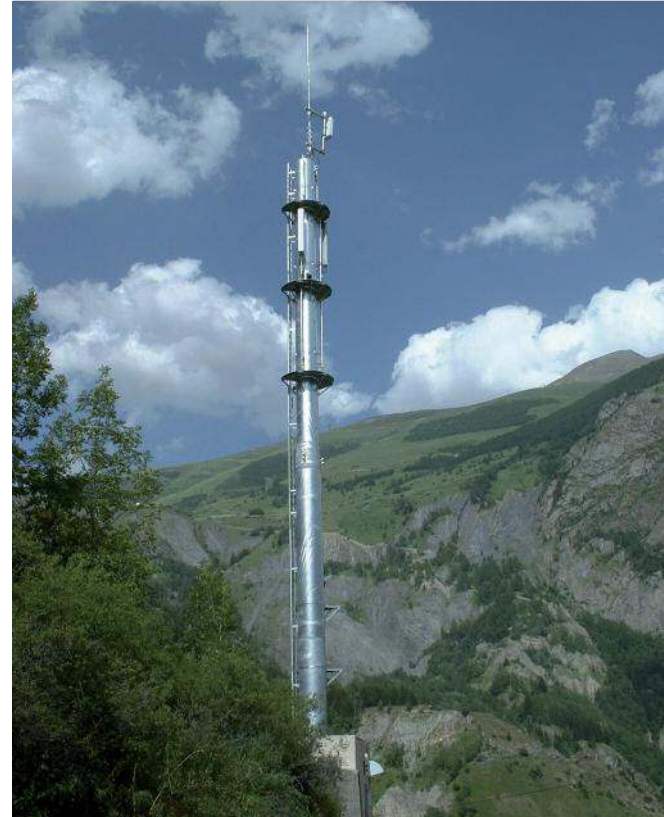
7.6-3 Application de produits galvanisés : antennes
